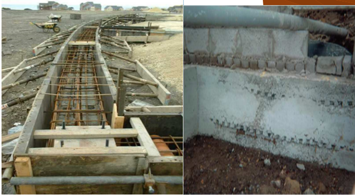
Longrines actuelles constituées de béton armé.
